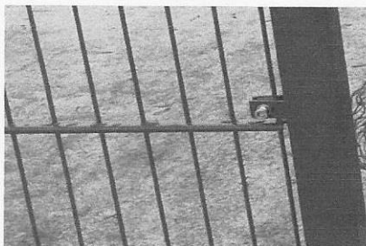
SPRÁVNÉ osazení ráků (v bezprostřední blízkosti sloupů)
