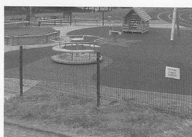
CHYBNÉ osazení ráků (velké mezery mezi ráky s chybně vymodelovaným terénem)
